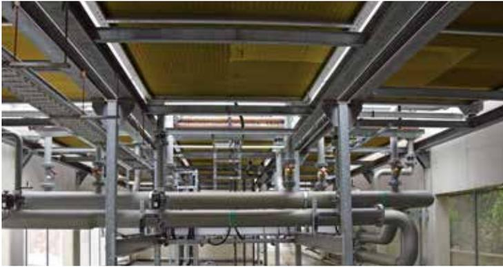
Am Dach der Kältezentrale wurden sechs neue Trockenkühler (Glykol-Kühler) in Tischkühlerbauform mit insgesamt 46 Ventilatoren installiert (hier die Sicht von der Zwischenebene auf die Unterseite).
